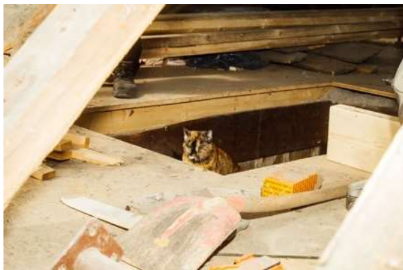
Unten wird gewohnt, oben wird umgebaut. © Max Slobodda für ZEIT ONLINE
